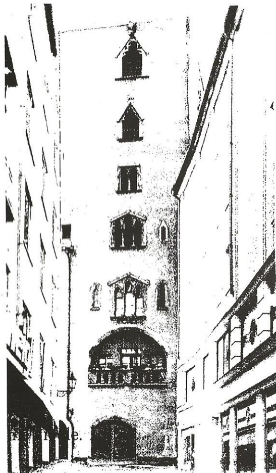
Maison des Baumburger - Facade nord de la tour.
